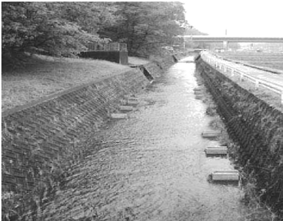
図4 施工後（2009年3月29日完成）
